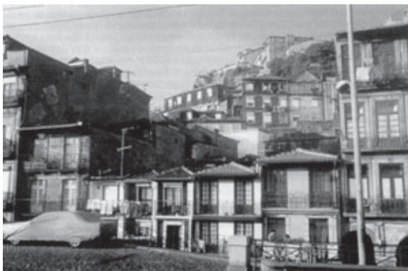
Estado actual do local onde existiu a Fábrica de Miragaia no Porto
