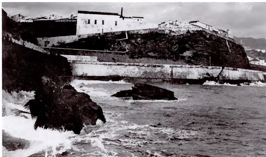
Lá no alto: a antiga “Fábrica da Rocha”, na Rua dos Canos Verdes, n.º 1.
