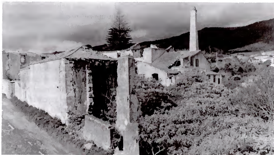
Ruínas da Fábrica do Álcool, em Angra do Heroísmo.
