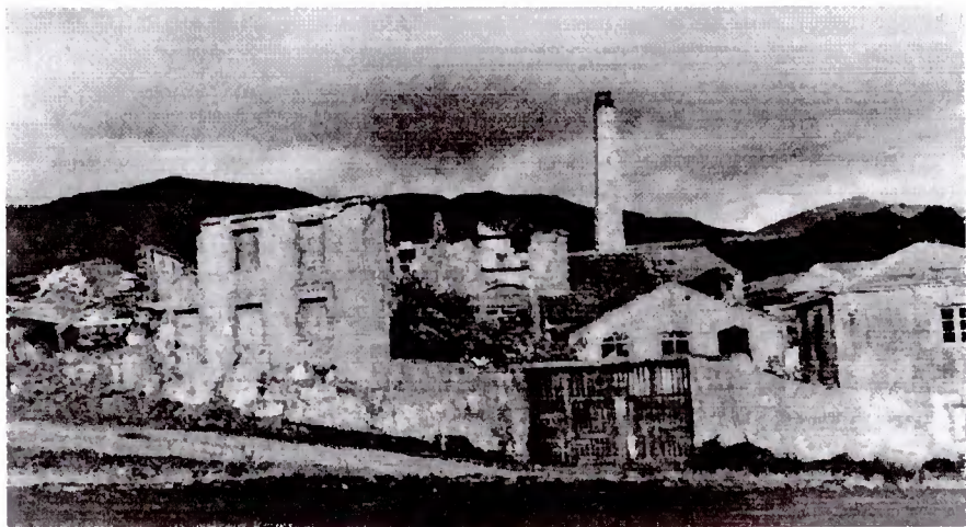
Outro aspecto das ruínas da Fábrica do Álcool, após o sismo de 1980, em Vale de Linhares, freguesia de S. Bento, Angra do Heroísmo.
