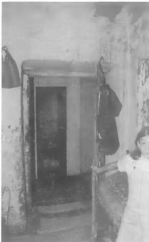
Figura 5. Vista de vão de porta interior com verga com bico
